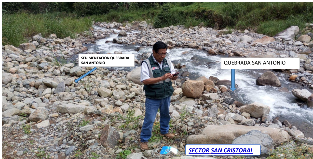
Figura N° 01: Se observa la colmatación, y vegetación en el cauce de la Quebrada San Antonio
